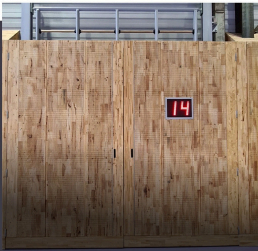
Foto 1 Wandrek in nis in de wand achter panelen die kunnen worden opengeklapt. Schotklok in de wand.
