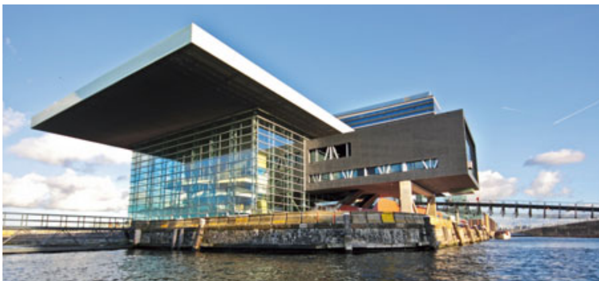
MUZIEKGEBOUW AAN 'T IJ, AMSTERDAM
