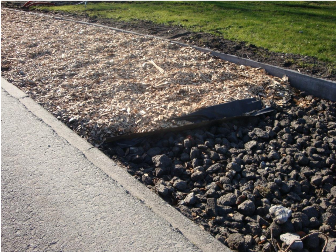
Foto 5 Plaatsing van tweede laag geotextiel en toplaag houtsnippers (Blosso, 2013c)
