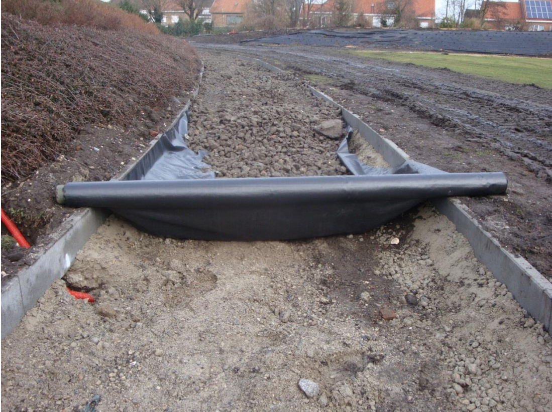
Foto 4 Plaatsing van eerste laag geotextiel en onderlaag steenslag (Blosso, 2013c)
