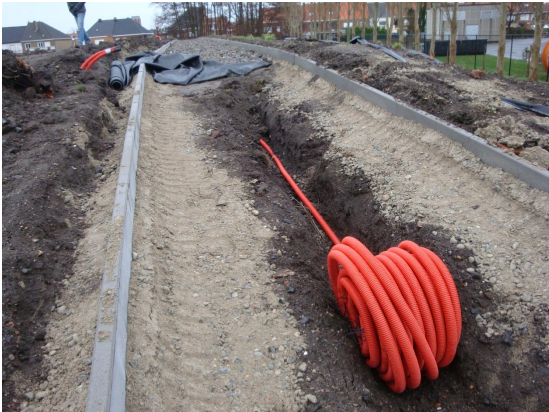
Foto 3 Voorbereidende basis met afwatering en boordstenen (Blosso, 2013c)
