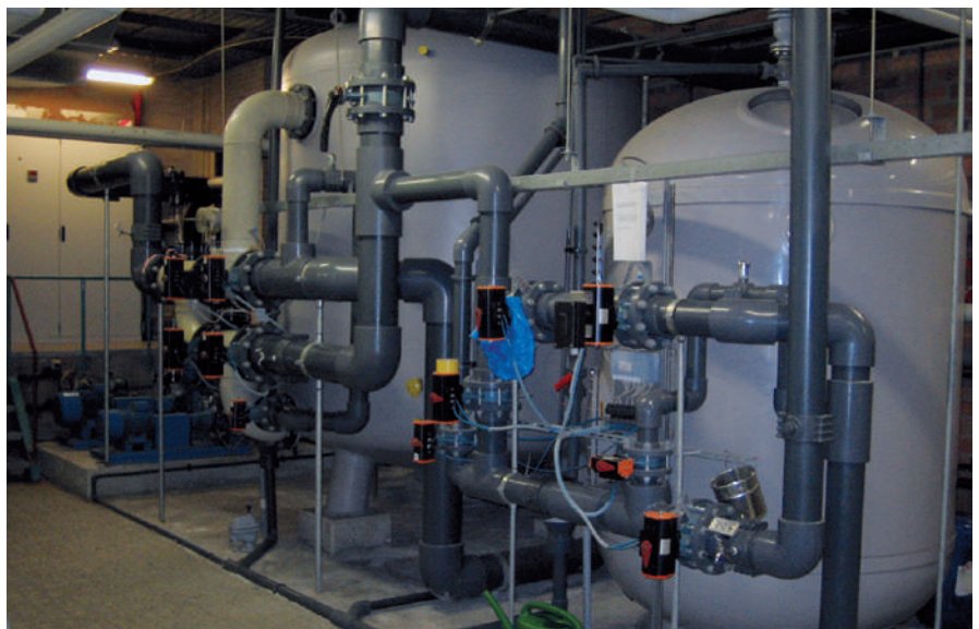
Installatie zwembad kerkpolder
