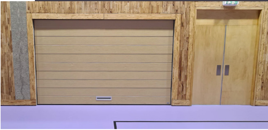
Foto 2 Segmentdeur en dubbele loopdeur naar toestellenberging. Kozijnen zijn afgerond.
