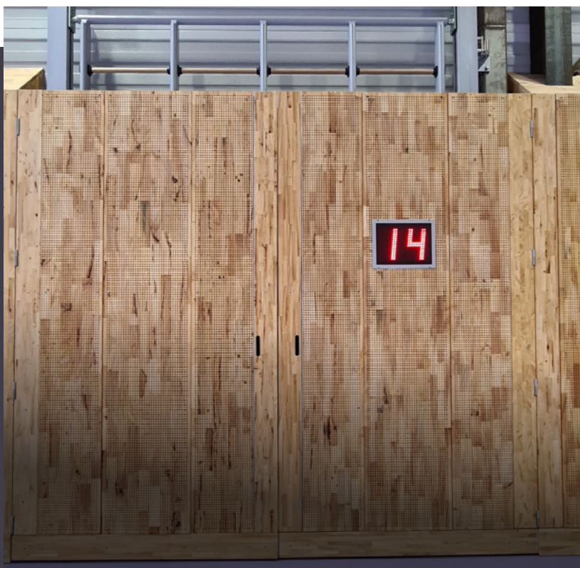
Foto 1 Wandrek in nis in de wand achter panelen die kunnen worden opengeklapt. Schotklok in de wand.
