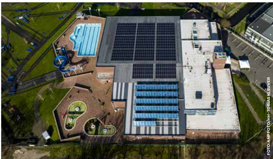
DOET GOED VOORBEELD GOED VOLGEN? OP HET DAK VAN HET GROENHOVENBAD IN GOUDA LIGGEN ZONNEPANELEN. DE VRAAG IS OF DAT DE INWONERS VAN DE STAD HEEFT AANGEZET TOT DUURZAAMHEIDSMATREGELEN THUIS.
