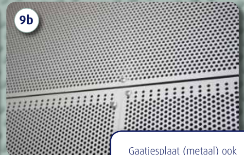
9b Gaatjesplaat (metaal) ook geluidsabsorberend
