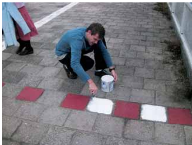
Structuur aanbrengen met betonverf
